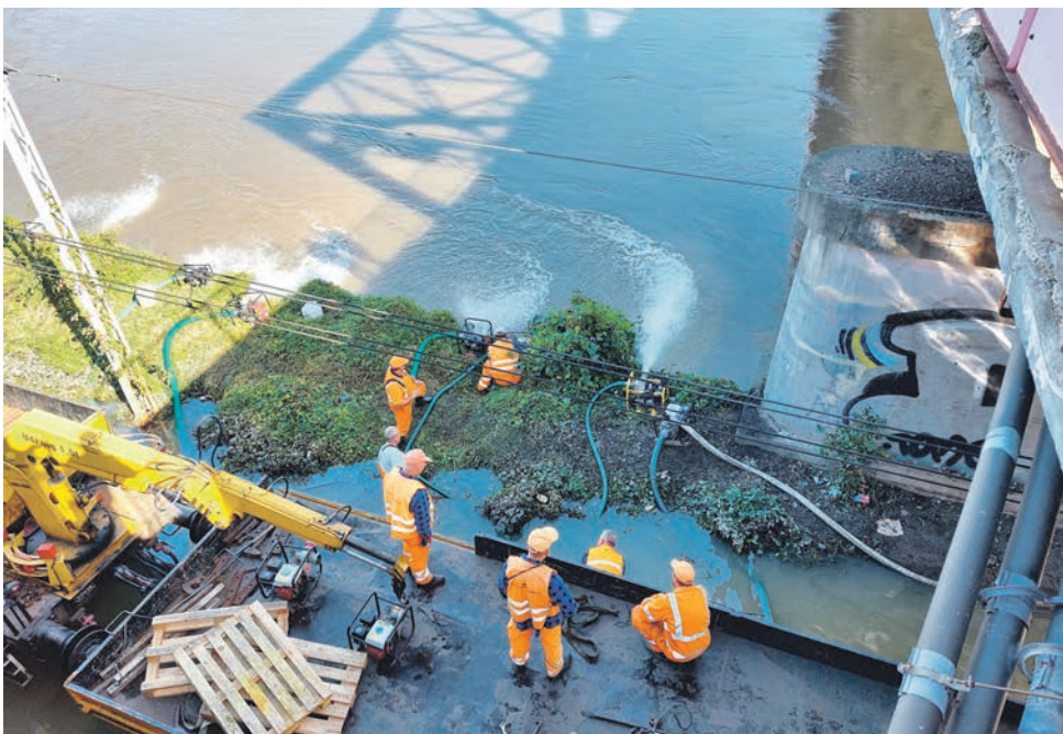
KADRA I SPRZĘT: Specjaliści z Jednostki Ratownictwa Górniczo-Hutniczego, którzy odpompowali wodę z zalanego torowiska w Głogowie, brali też udział w zabezpieczaniu wałów Odry w Ścinawie. [FOT. ARC]
